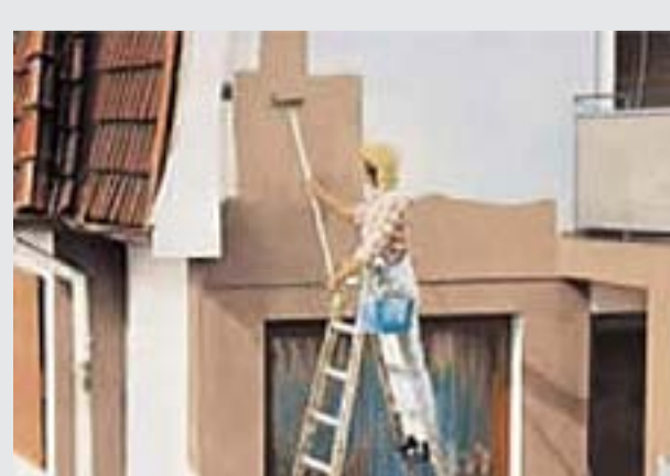
6 - Pitturazione con la pittura ai silossani PROTECH SIL-P
