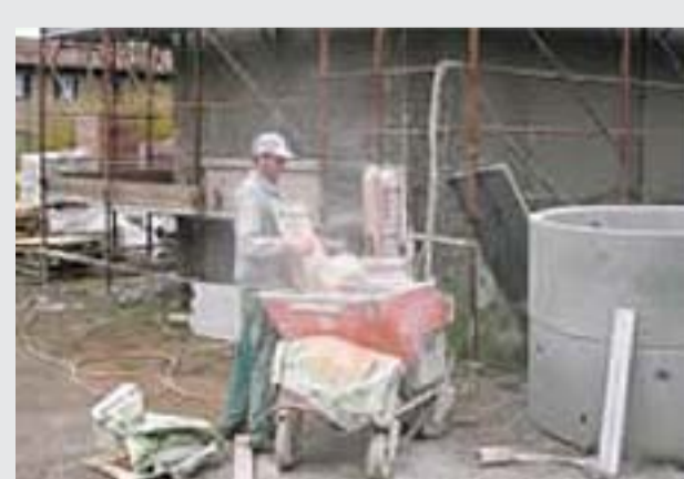
1 - Inserimento dei prodotti nell'intonacatrice
