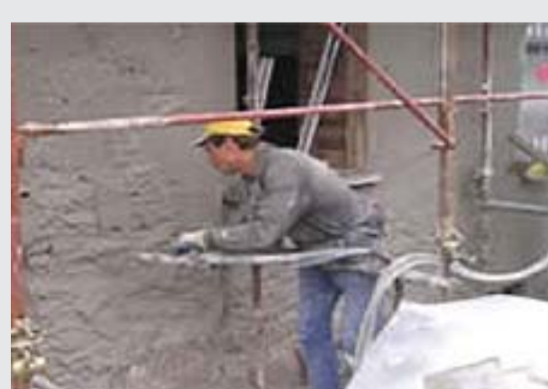
3 - Applicazione del termointonaco SANAWARME
