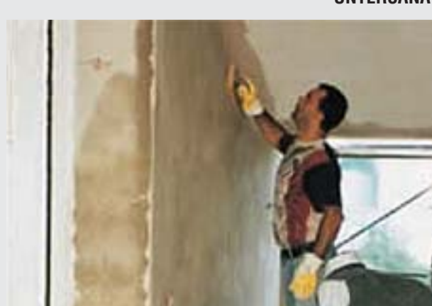
5 - Finitura omogeneizzante con il rasante SANASTOF
