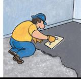
**4** Posa in opera e frattazzatura della malta cementizia di cui sopra, sino a realizzare lo spessore, le quote e le eventuali pendenze previste, ivi compresa la finitura e lisciatura dell'estradosso, ove richiesta, mediante frattazzatrice meccanica.
