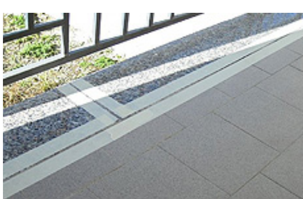
2) Preparazione dei giunti di possibile movimento, al successivo riempimento con sigillante poliuretano elastico
