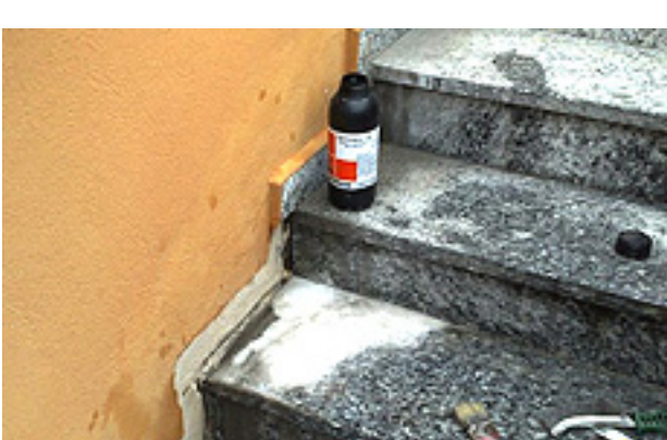
1) Pulizia profonda della pavimentazione piastrellata, mediante l'utilizzo dello specifico detergente acido DETERG - A
