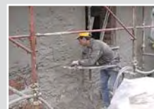
3) Applicazione del termointonaco SANAWARME
