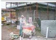
1) Inserimento dei prodotti nell'intonacatrice
