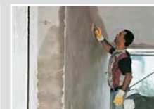
5) Finitura omogeneizzante con il rasante SANASTOF
