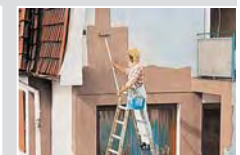
6) Pitturazione con la pittura ai silossani PROTECH SIL-P
