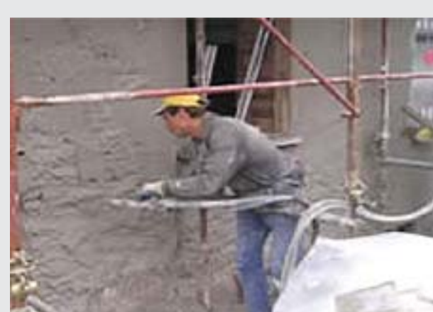
3 - Applicazione del termointonaco SANAWARME
