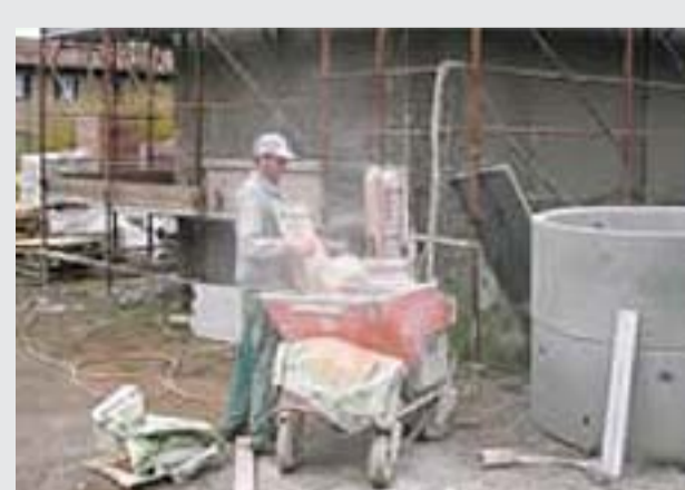
1 - Inserimento dei prodotti nell'intonacatrice
