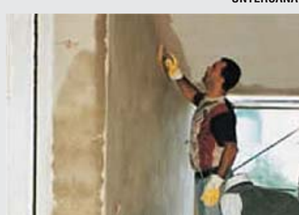
5 - Finitura omogeneizzante con il rasante SANASTOF
